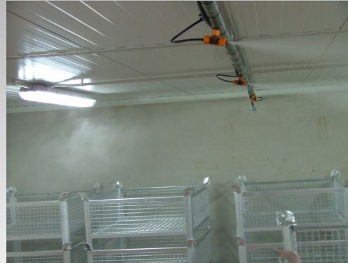
CÁMARAS HÚMEDAS HORMIGÓN
