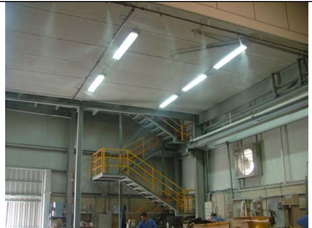
Combinación de nebulización y ventilación-extracción para neutralizar con el 100% de eficiencia el polvo ambiental y partículas en suspensión generado en Industria Marmolera.
