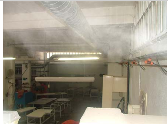
Boquillas nebulizando en planta Marmolera. Regulación de tamaño de gota y caudal ajustables por el usuario.
