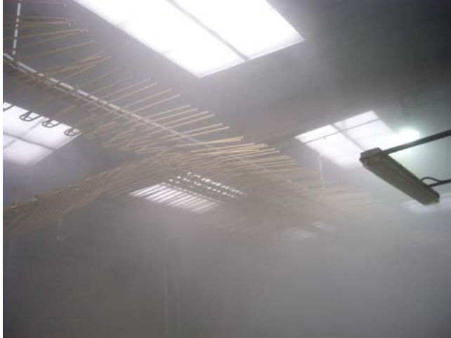
Puesta en marcha y prueba de homogeneización de humedad ambiental en todo el volumen de la industria de curtido de pieles
