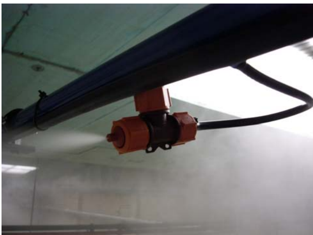
Detalle boquilla FICFOG humidificando. NOTA: la boquilla es orientable 360º para obtener máxima homogeneización
