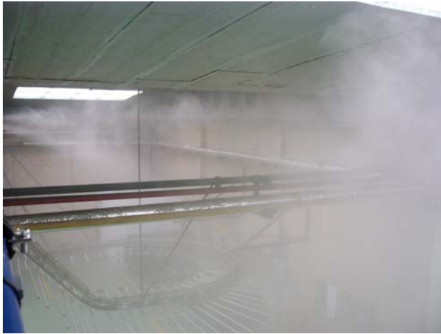
Prueba post-puesta en marcha de homogeneización de la humidificación ambiental En el aéreo de la industria de curtidos
