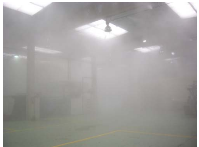
Prueba homogeneización de la humidificación en el volumen de la nave de curtidos
